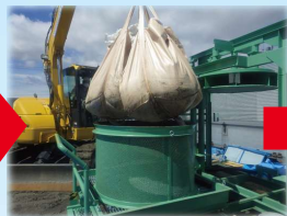
透水性バッグを 加圧型脱水機へ
